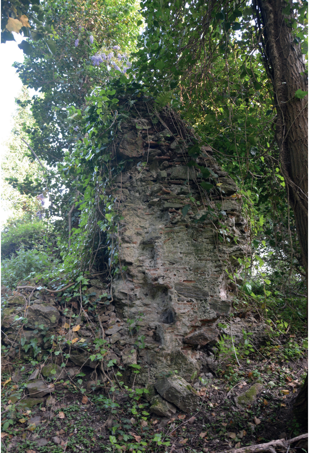
Fig. 11. Angolo sud-est del palazzo con evidenti segni di asportazione dei conci ad opus quadratum (foto F. Sciara).
