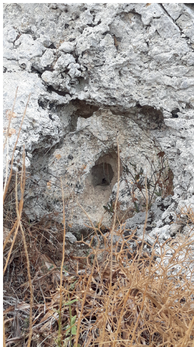
Fig. 2. Id. foro passante alla base dell'arco e corrispondente apertura sulla parete con orientamento 60°-240°.
