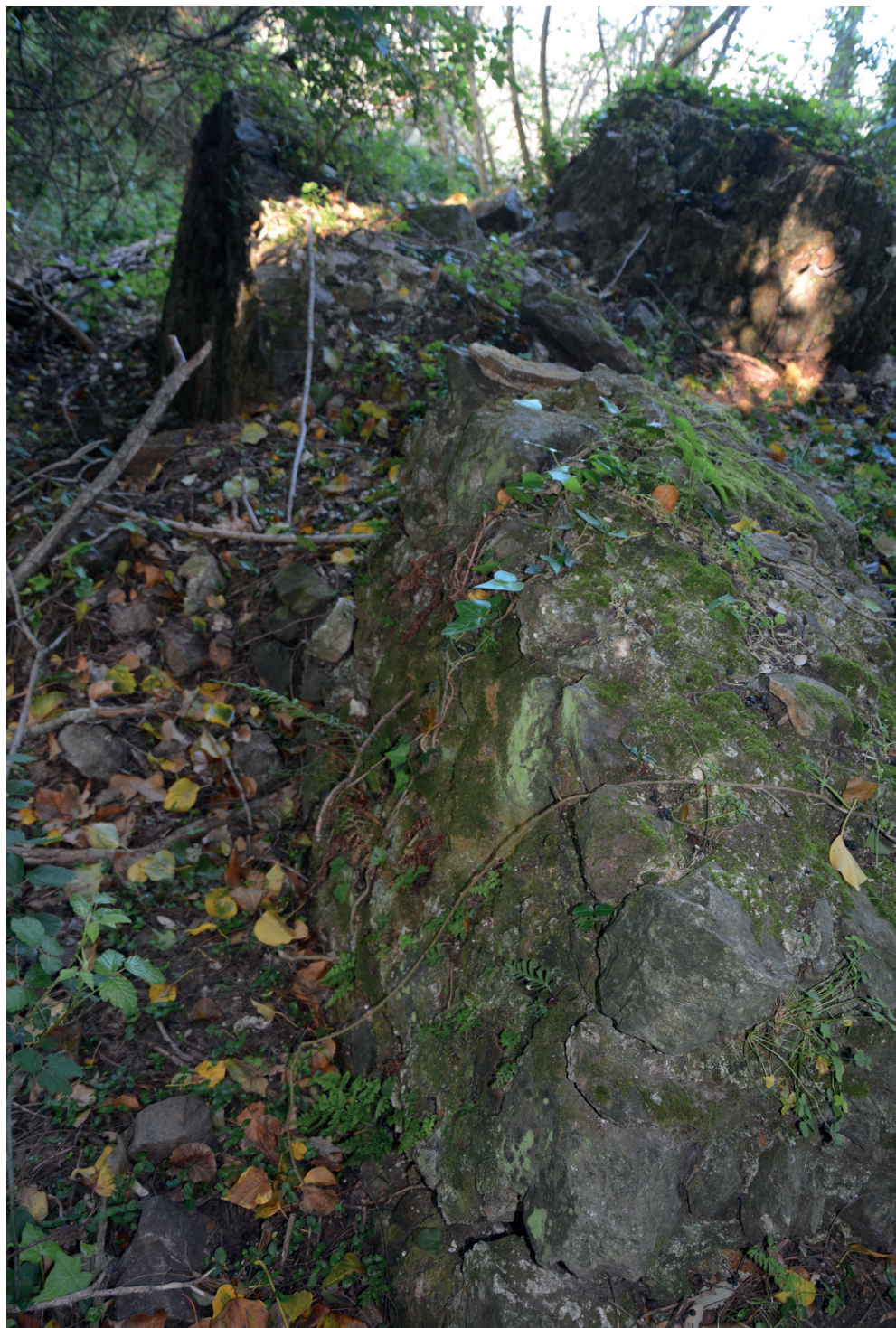
Fig. 14. Visione di un tratto di muro oggi quasi completamente distrutto (foto F. Sciara).
