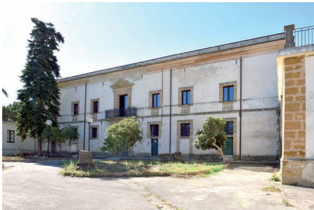
Veduta della facciata laterale del Convitto, lato Ovest.
