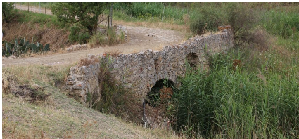
Figura 8. Il ponte Canale sotto l'abitato di Mazzarino.
