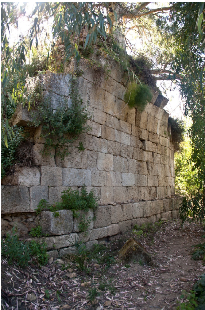
Figura 5. Il muro d'appoggio del ponte Niscima visto dal lato valle.
