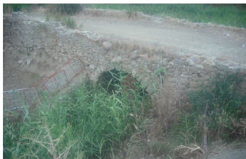
Figura 9. L'arco del ponte Canale.
