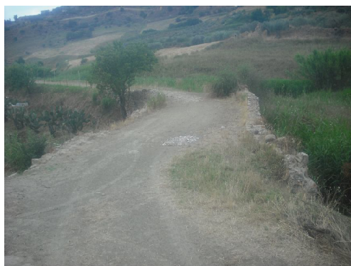
Figura 10. La parte carrabile del ponte Canale.
