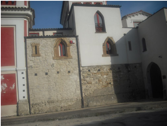
Figura 6 - Un particolare del prospetto principale. Si vedono, al 1° piano, da sinistra una feritoia più complessa, al centro due finestre chiaramontane e, più a destra, una feritoia semplice.
