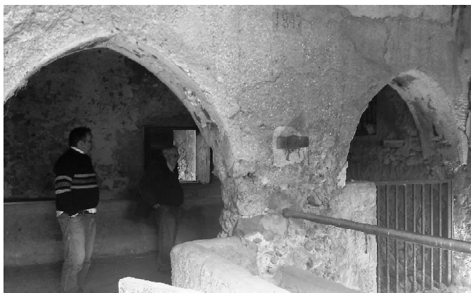
Figura 7. Masseria Albiata: archi a sesto acuto interni.
