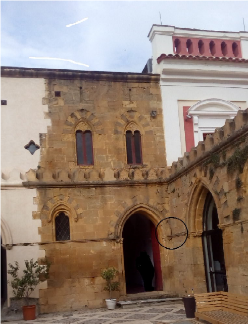
Figura 19. Facciata laterale di Villa Barrile. Nel cerchio la sovrapposizione dell'edificio più recente, a destra (possibile fine XIX secolo), che copre una porzione dell'arco a sesto acuto (forse XV secolo).
