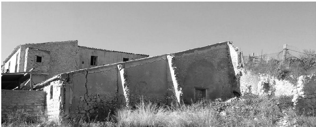
Figura 9. Masseria Albiata: parete addossata alla roccia secondo un tipico utilizzo delle costruzioni dei secoli precedenti.
