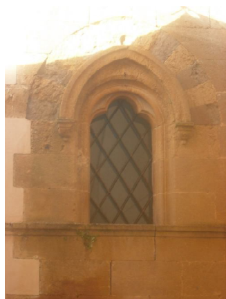
Figura 7 - Una finestra chiaromontana al 1° piano nel prospetto Ovest.
