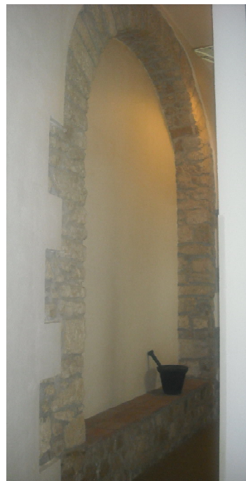
Un altro arco a tutto sesto collegante il corpo che si affaccia su via Xiboli ed il corpo posteriore del Convento.
