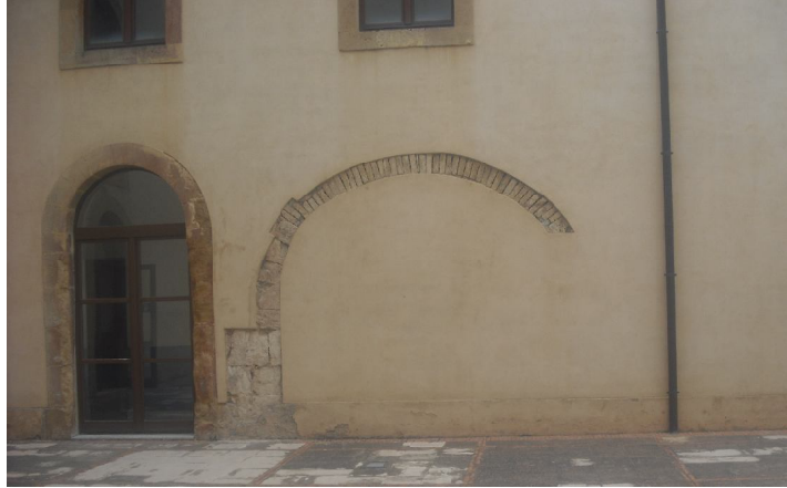
Un arco a tutto sesto originale appartenente al corpo che divideva in due l'attuale cortile centrale dell'ex Ospedale.
