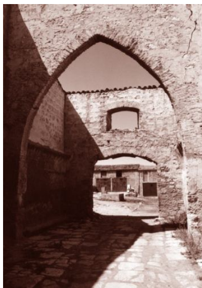
L'arco a sesto acuto probabilmente del XIV secolo che rivela la presenza di una torre di guardia.
