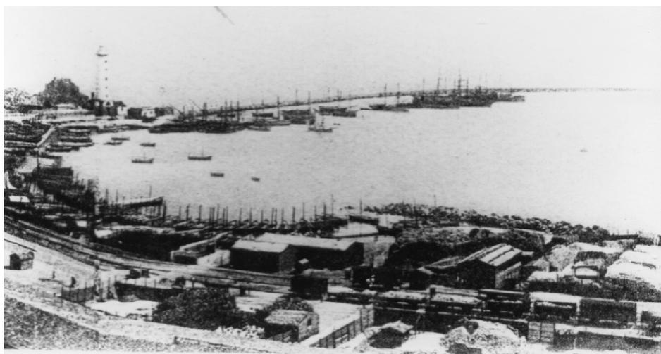
Vista da monte del Porto di Licata; sullo sfondo il Faro ed il molo di levante realizzato con i resti provenienti dalla demolizione del Castello di San Giacomo. In primo piano la ferrovia, completata nel 1881. Datazione presunta: anni 1920/22.
