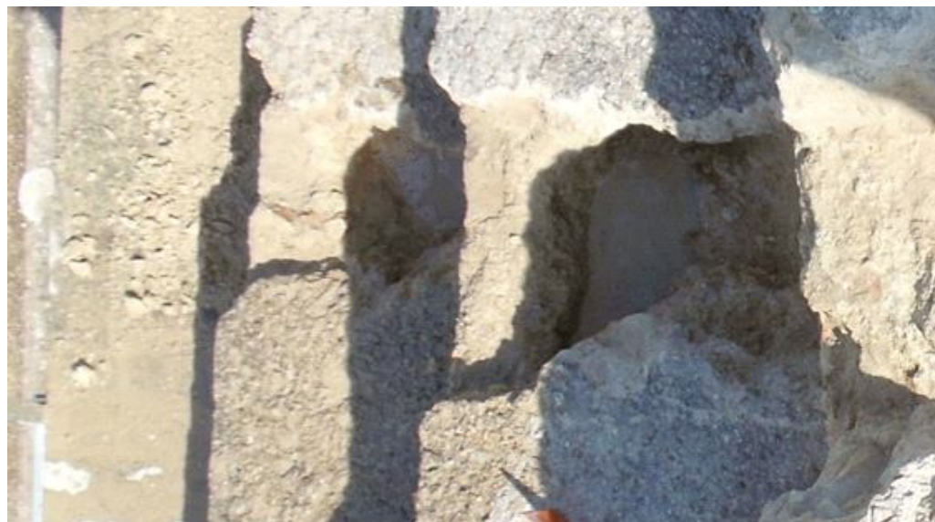
Figura 12 - Saggio eseguito nella superficie estradossale della copertura gradonata.
