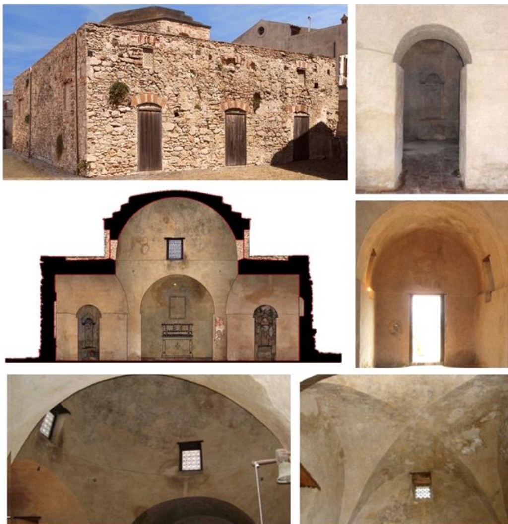
Figura 4 - Caratteristiche plastico-architettoniche della struttura.
