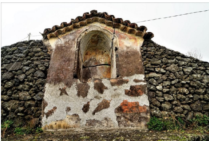
Figura 9 - Belpasso (CT), cisterna della regina: altare.
