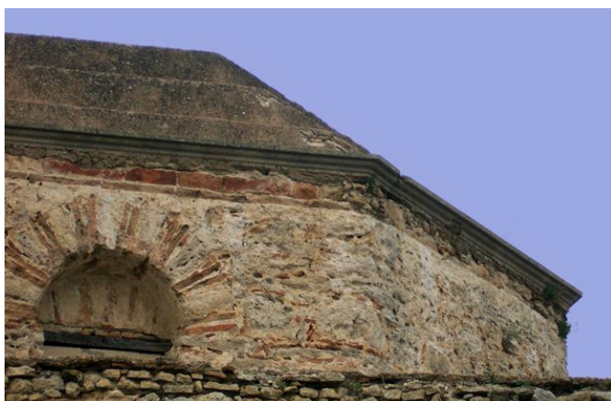
Figura 6. Rometta, chiesa di Santa Maria dei Cerei. Particolare della cornicetta del tamburo ripristinata da Valenti.
