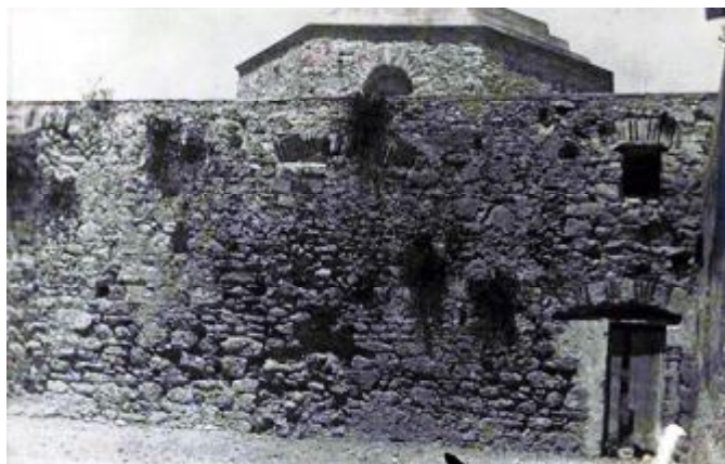
Figura 10. Rometta, chiesa di Santa Maria dei Cerei, prospetto orientale prima dei restauri di Francesco Valenti (stampa fotografica). Le superfici del tamburo ottagonale risultano già libere dal manto preesistente di intonaco.
