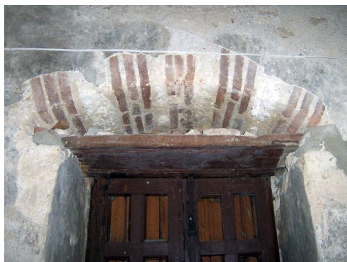
Figura 1. Rometta, chiesa di Santa Maria dei Cerei. Tessitura ad opus mixtum nell’arco ribassato della porta centrale (fronte est).
