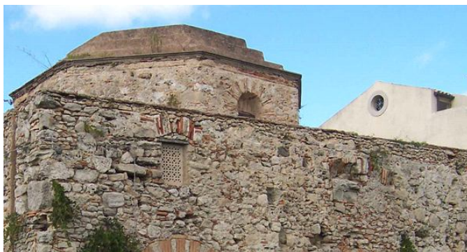
Figura 5. Rometta, chiesa di Santa Maria dei Cerei, fronte est. Coronamento d'attico con copertina di mattoni "pantofoloni" scelta da Valenti.
