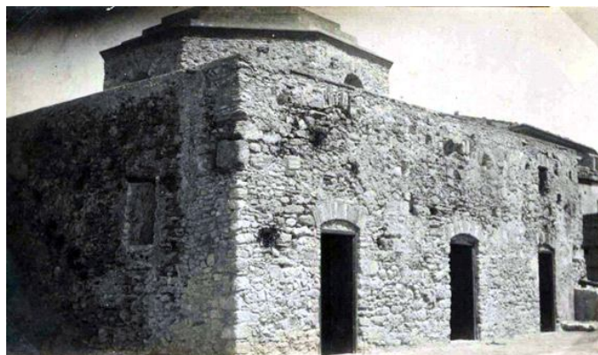
Figura 20 . Rometta, chiesa di Santa Maria dei Cerei (stampa fotografica). Esito dei restauri a seguito della riapertura dei tre ingressi orientali (post 1919).
