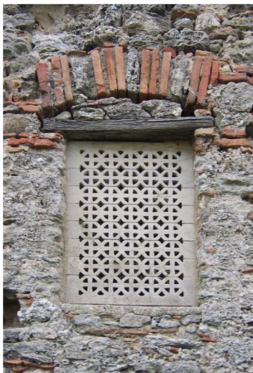
Figura 21- Rometta, chiesa di Santa Maria dei Cerei. Transenna in pietra di Melilli di una finestra (fronte settentrionale).
