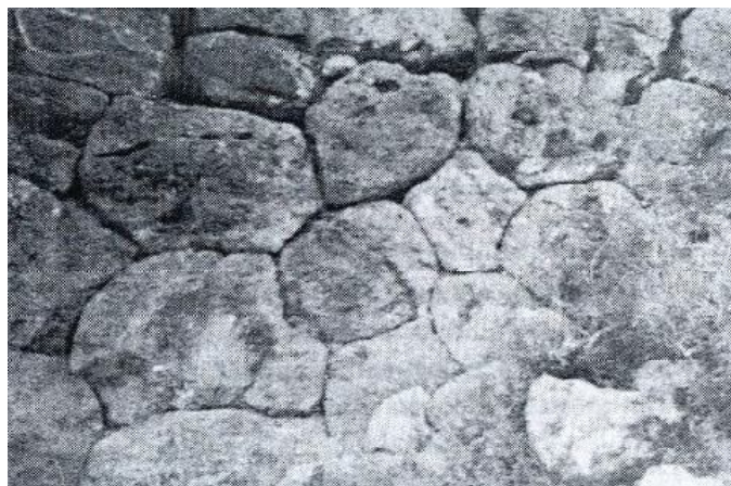
Figura 3. Lesbian masonry (SCRANTON, Greek Walls , cit., p. 34).
