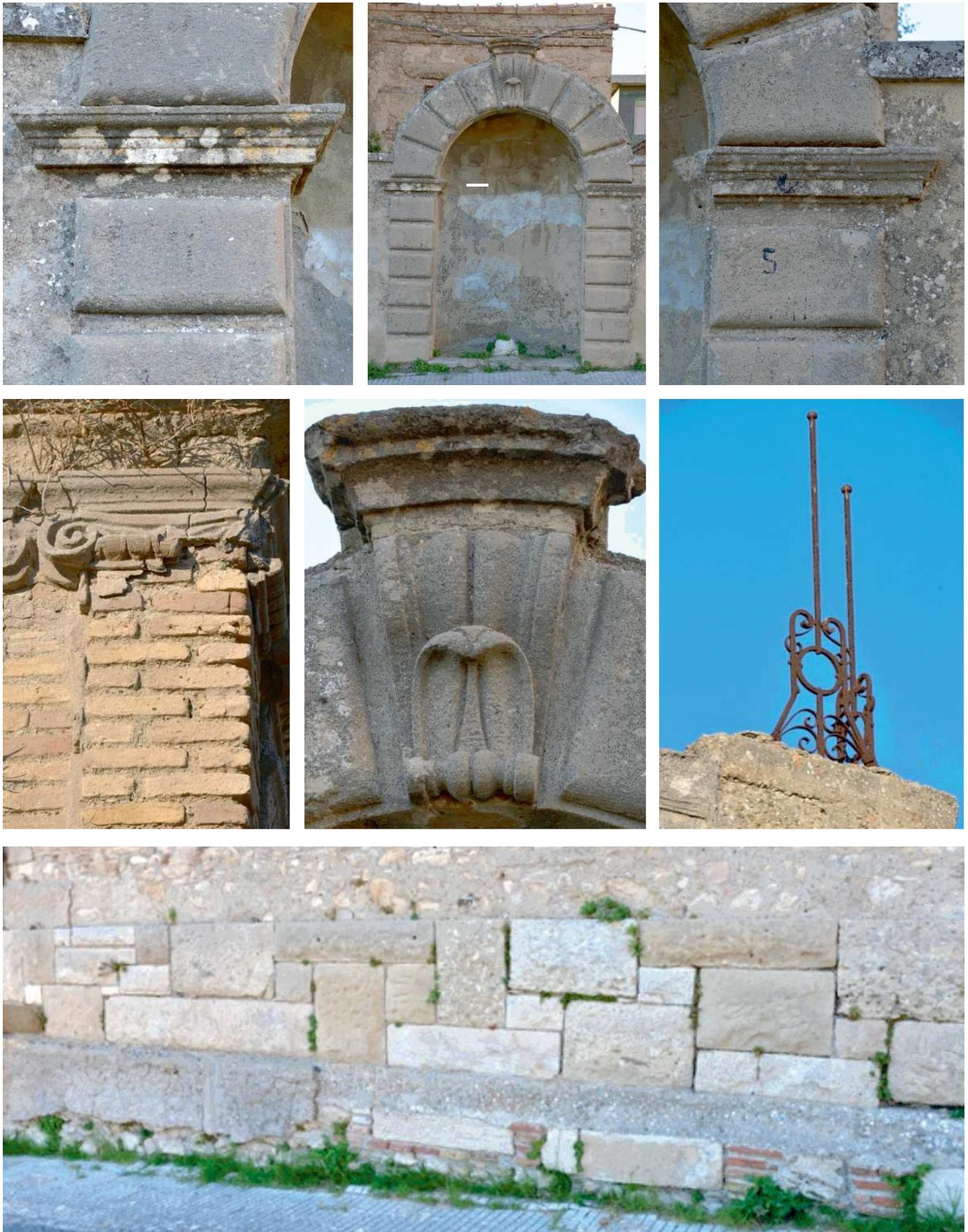
Figura 8. Resti architettonici del monastero della SS. Annunziata (foto del Dott. Giovanni Rigano). In alto, al centro, il portale d'ingresso con la chiave di volta dell'arco e i piani d'imposta; al centro, a sinistra, particolare di un pilastro in mattoni di epoca recente; al centro, a destra, elementi in ferro battuto in stile liberty installati sopra le mura dell'edificio adibito a scuola ed oggi ridotto a rudere; in basso, conci squadrati provenienti dal vecchio monastero.
