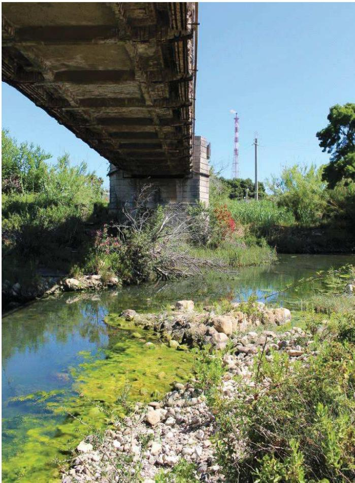
**Figura 15.** A lato: nel greto del fiume, proprio sotto la campata moderna in c.c.a., si trovano ancora i resti di due pile del ponte più antico realizzate a sacco: esternamente con pietre di piccolo taglio ed internamente con conglomerato cementizio che fanno pensare ad un'origine romana.
