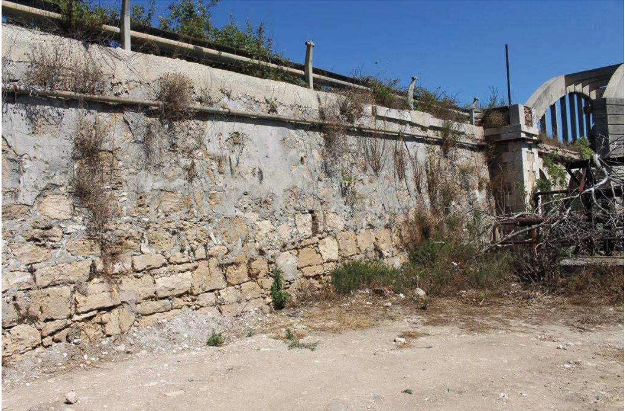
**Figura 14.** In alto: il muro d'ala del ponte antico composto da pietre di vario formato, squadrate in maniera grossolana, di uguale fattura di quelle utilizzate per le pile, sovrastate da un cordolo in c.c.a. di collegamento e rinforzo.
