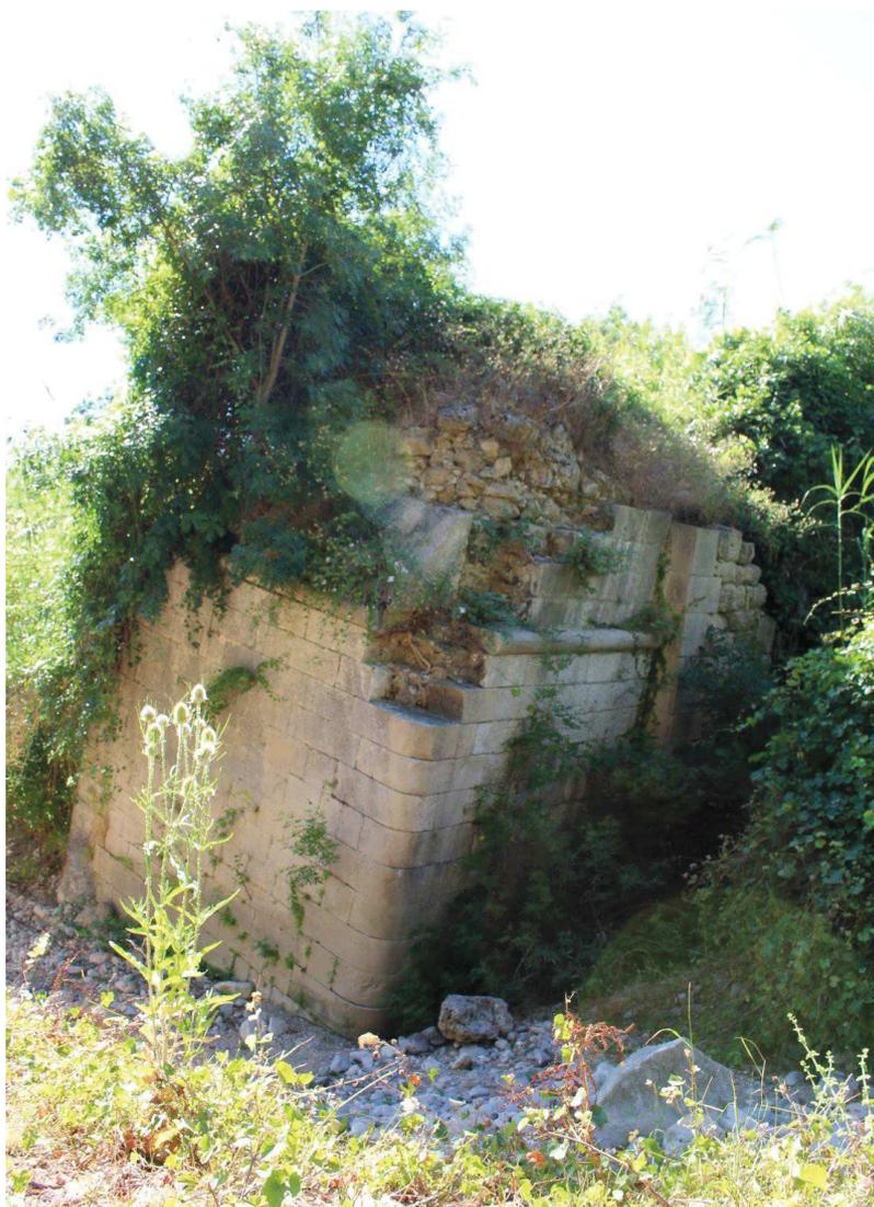
**Figura 12.** A lato: uno dei due muri iniziali del ponte, realizzato con parziale riutilizzo di strutture precedenti, ormai totalmente inclinato, costruito con pietra di elevata fattura e definito da un toro all'altezza dell'attacco della volta, presumibilmente a tutto sesto.
